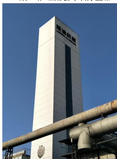
厂区废气总排气筒
